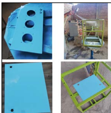
Figura 4: construcción del prototipo
