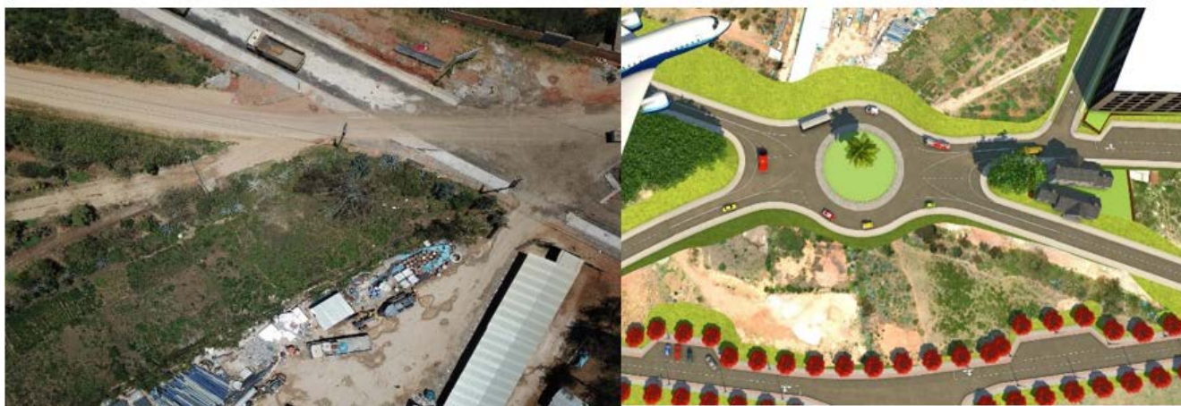
Figura 7. a) intersección actual, tomada con RPAS y b) intersección de vías con rotonda
