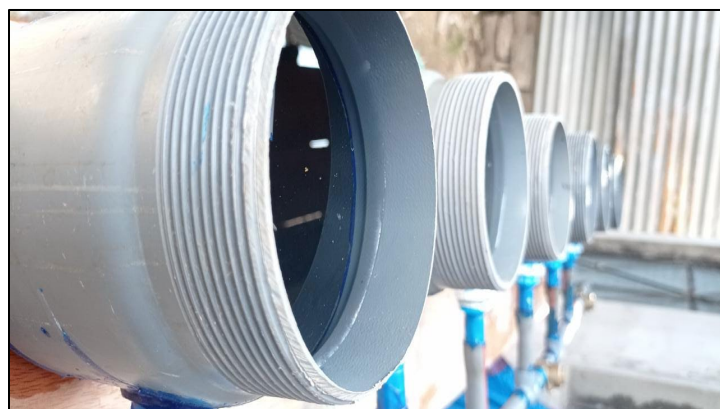
Figura 12. Pruebas hidráulicas realizadas para el conocimiento existente de fugas en el biorreactor
